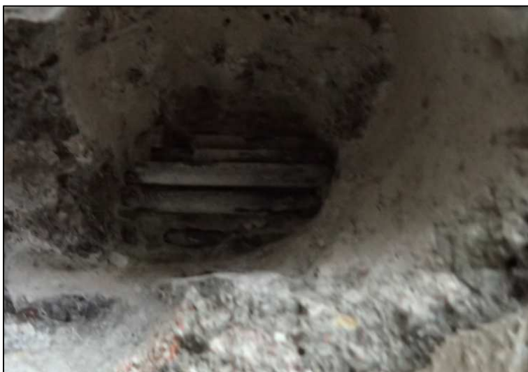
Obrázek 46 - sonda D10, povrchová koroze výztuže, kanálek zainjektovaný
