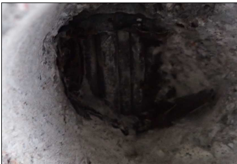
Obrázek 45 – sonda D9, povrchová koroze výztuže, kanálek zainjektovaný
