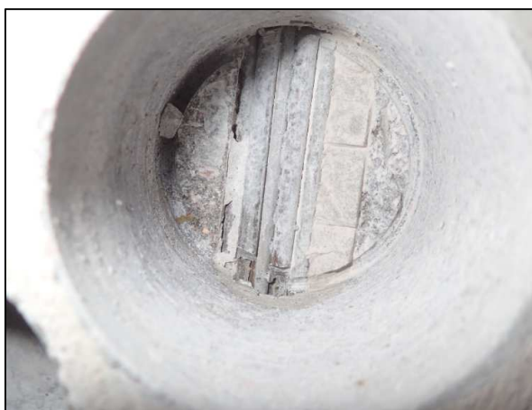
Obrázek 32 – odkrytá předpínací výztuž, bez koroze, zainjektovaná
