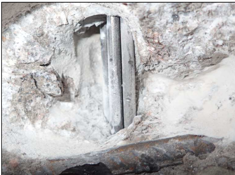
Obrázek 38 - sonda D2, výztuž bez koroze, kanálek zainjektovaný
