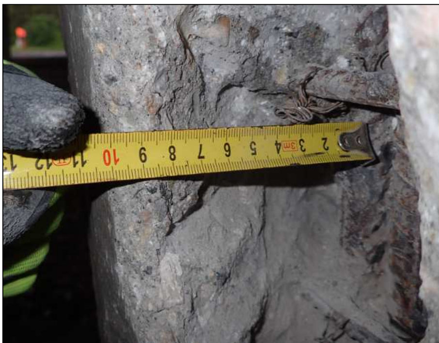
Obrázek 53 – sonda ve sloupu, krytí 100 mm
