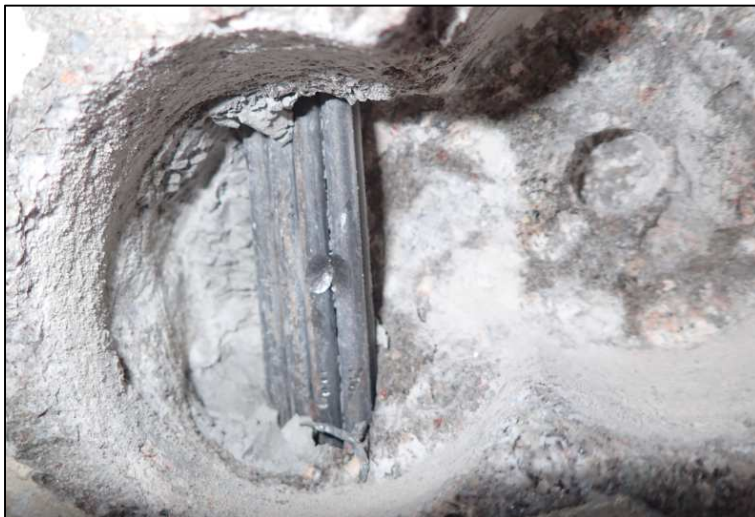
Obrázek 37 - sonda D1, výztuž bez koroze, kanálek zainjektovaný
