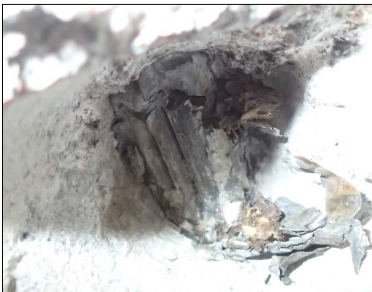
Obrázek 42 – sonda D6, výztuž bez koroze, kanálek zainjektovaný
