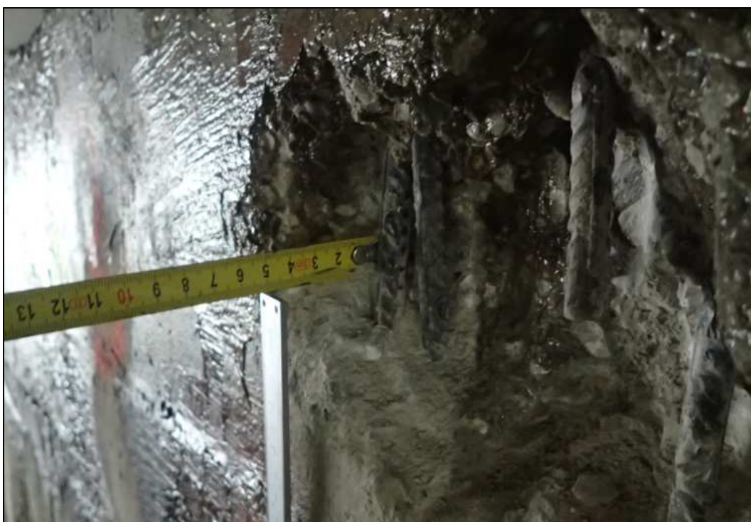
Obrázek 57 – sonda v opěře 5, krytí 50 mm
