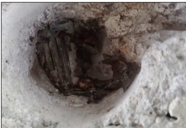
Obrázek 41 sonda D5, povrchová koroze výztuže, kanálek zainjektovaný
