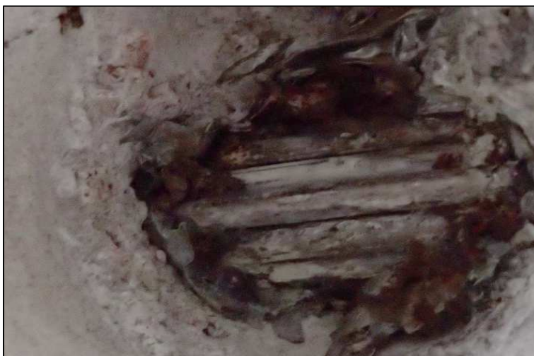
Obrázek 43 - sonda D7, povrchová koroze výztuže, kanálek zainjektovaný
