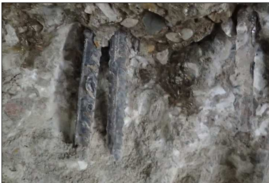
Obrázek 55 – sonda v opěře 5, koroze povrchová
