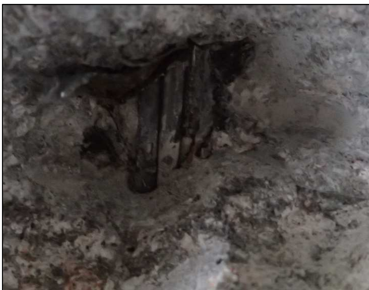
Obrázek 44 - sonda D8, povrchová koroze výztuže, kanálek zainjektovaný
