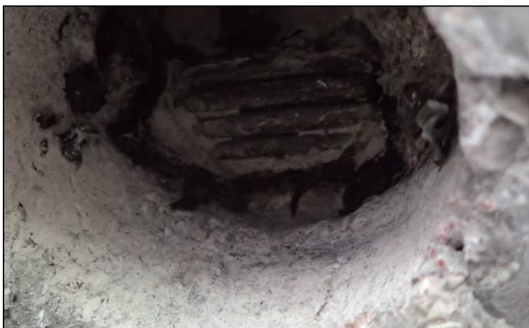
Obrázek 40 - sonda D4, povrchová koroze výztuže, kanálek zainjektovaný
