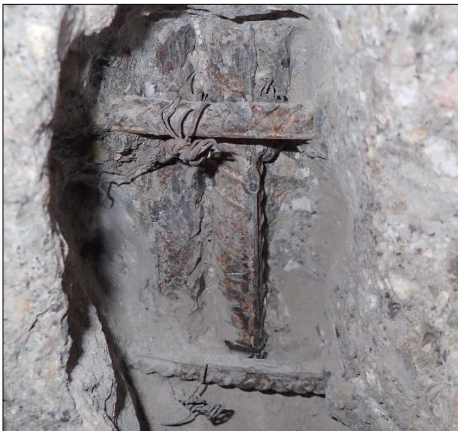
Obrázek 52 – sonda ve sloupu, svislá výztuž Ø 18 mm, třmínky Ø 10 mm
