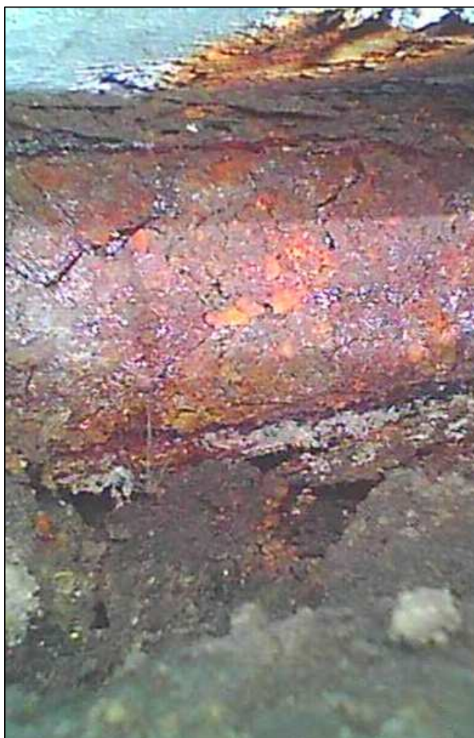
Obrázek 61 – podpěra č. 2, foto z endoskopu, koroze ocelové úložné desky
