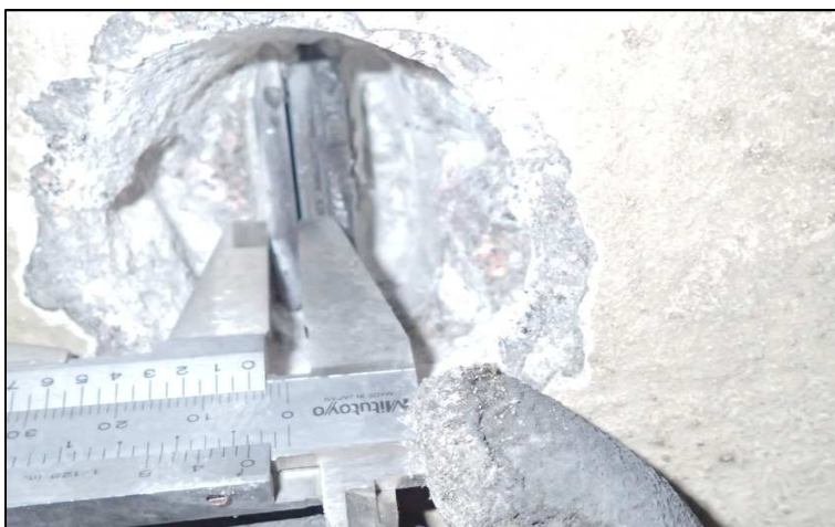
Obrázek 47 - sonda D11, výztuž bez koroze, kanálek zainjektovaný
