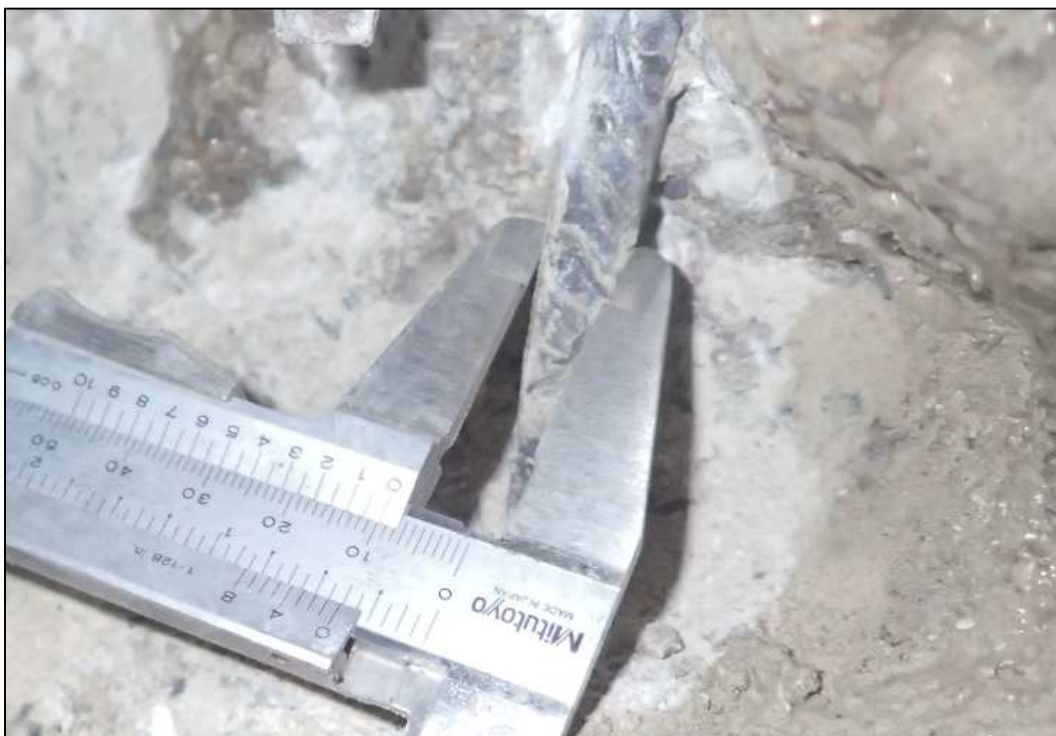
Obrázek 56 - sonda v opěře 5, svislá výztuž Ø 10 mm, koroze povrchová
