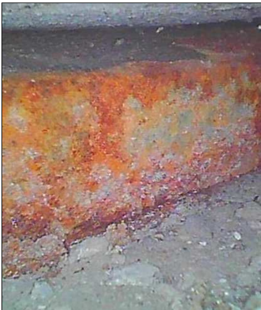
Obrázek 62 – podpěra č. 4, koroze úložné desky
